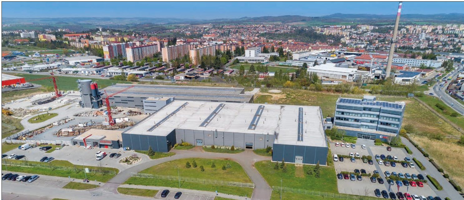
Werkstätten mit Verwaltungsbau S.O.K.
