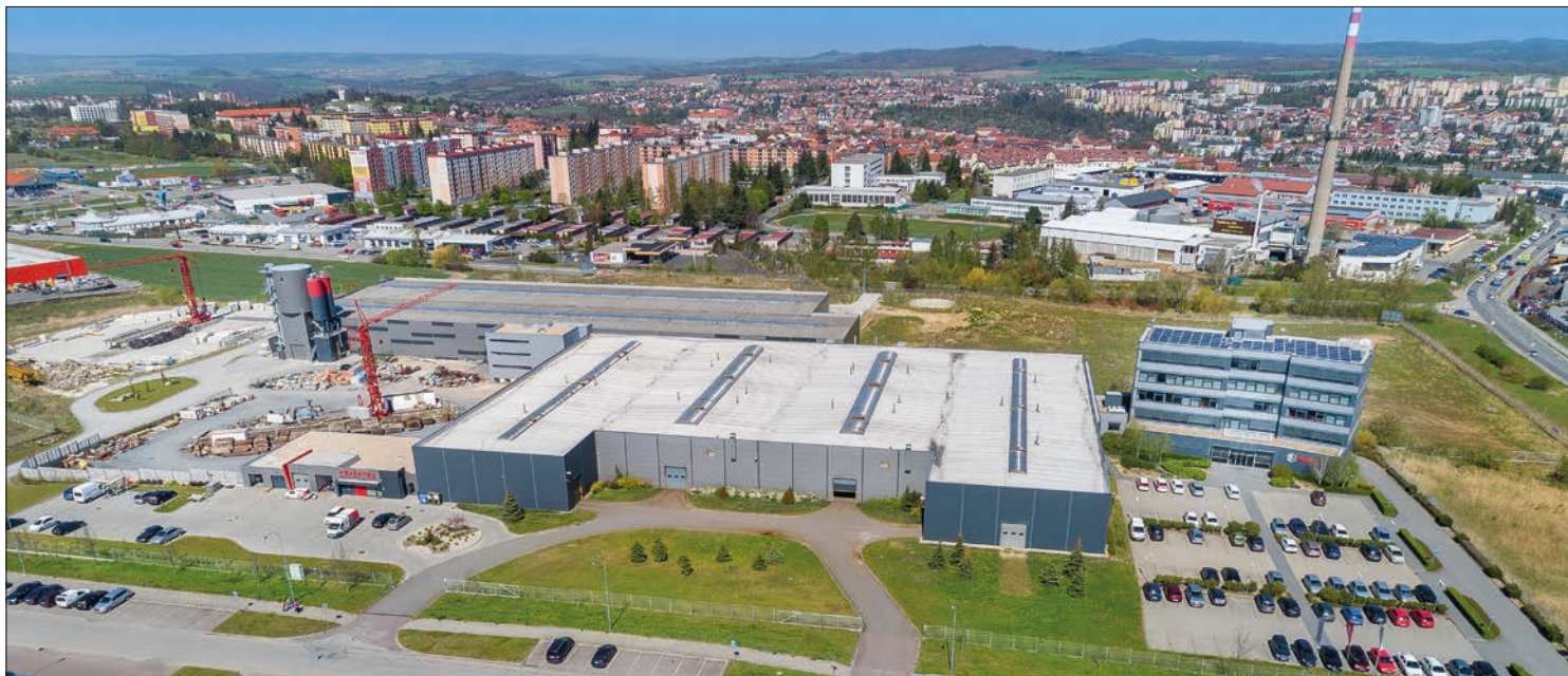
Výrobné haly s administratívnu budovu S.O.K
